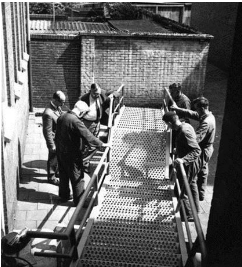
Het plaatsen van de stalen buitentrap.
